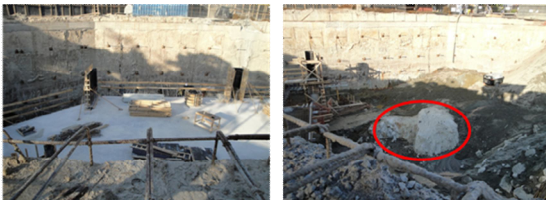
Figura 19 - Processo de execução em meia laje como solução para maior flexibilidade
