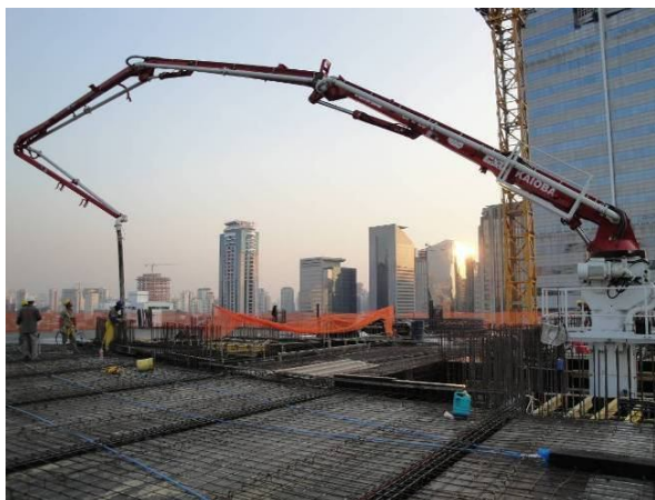
Figura 49 – Mastro de concreto em ação
